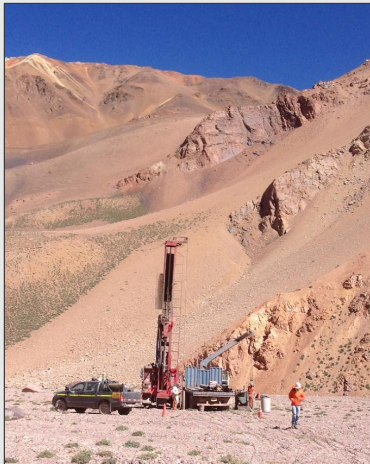
Perforación Pozo Llano de las Liebres
